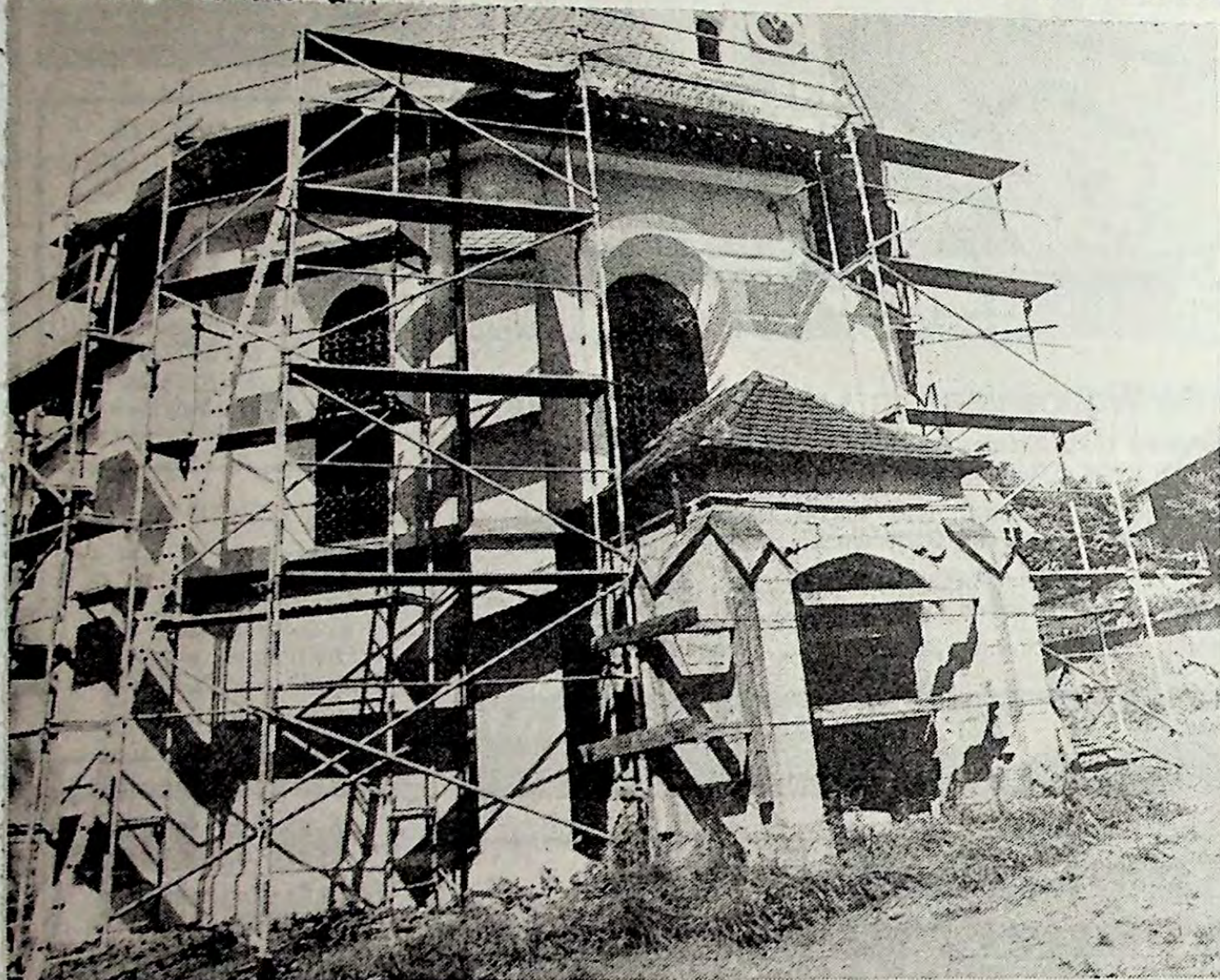
Mit 35 000 DM Zuschuß an die Evangelische Pfarrgemeinde Großengsee bezuschußt der Landkreis die komplette Außenrenovierung der alten, wertvollen Kirche in St. Helena. Die Arbeiten sind in vollem Gang Fotos: PZ
