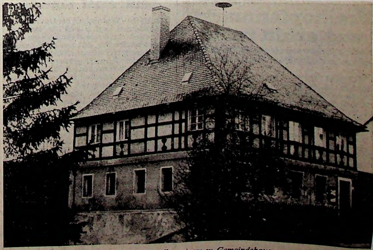
Die ehemalig Schule Großengsee soll zu einem ev. Gemeindehaus ausgebaut werden.
